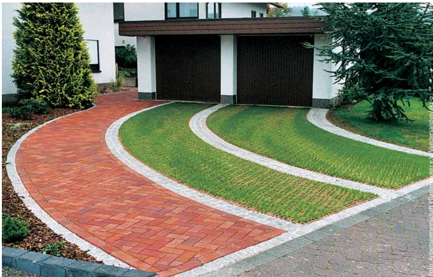
Begrünbare Pflasterklinker mit Ausparungen, sogenannte Rasenlochklinker, tragen zur Entsiegelung von Flächen bei und lassen Regenwasser direkt in den Boden versickern.
