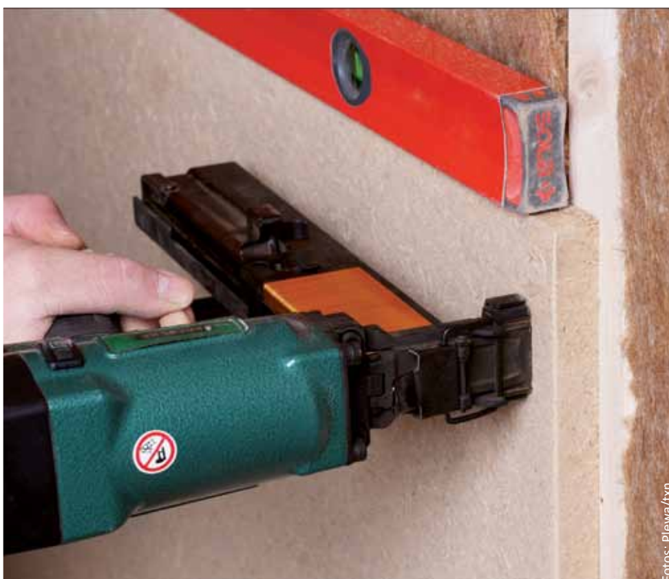
Lehmbauplatten regulieren das Raumklima, verbessern den Schall- und Brandschutz und lassen sich ebenso leicht verarbeiten wie Gipskartonplatten.
