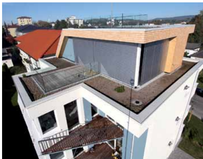
Die Schaffung von zusätzlichem Wohnraum auf dem Dach wird durch den Bau-Turbo-Pakt mit weniger Bürokratieaufwand möglich.
